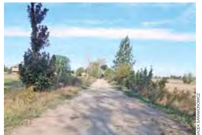
Tak wygląda droga w Gołędzkim teraz, po utwardzeniu tłuczniem. Wkrótce będzie na niej asfalt.
