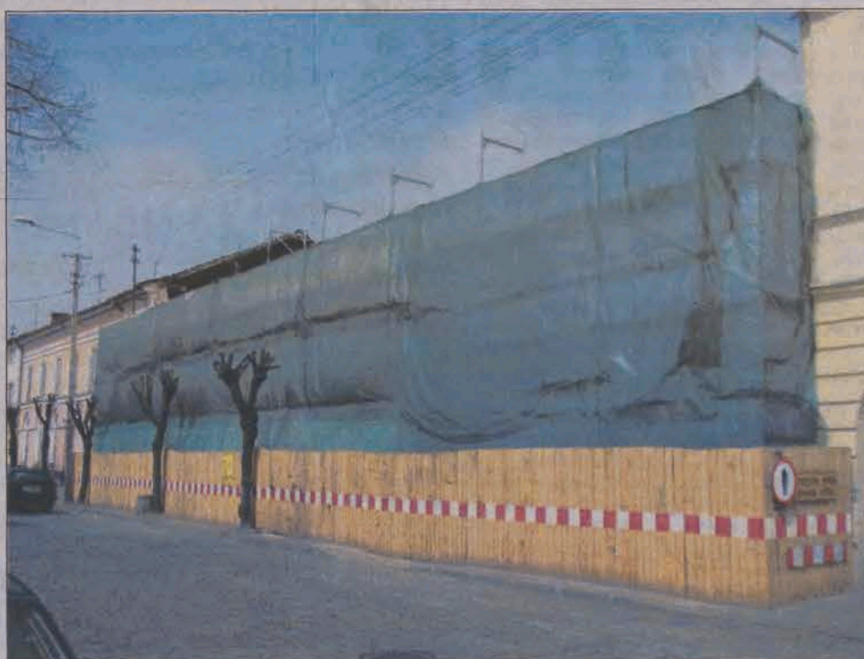
Za siatką i rusztowaniem jest tylko frontowa ściana, ale także nie cała - po prawej stronie widać, że trzeba było ją fragmentem rozebrać, bo nie rokowała swym stanem, że wytrzyma remont.
