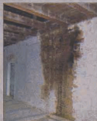
Zacieki, wilgoć - po skuciu tynków widać, że ściany są w złej kondycji.
