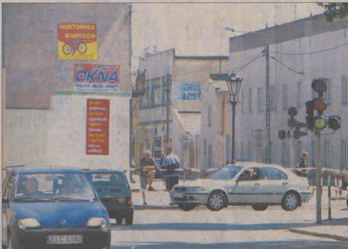
Patrząc od strony Długiej widać, że kamienica, na której widnieją szyldy utrudnia wyprostowanie skrzyżowania - dlatego jest przeznaczona do wyburzenia.
