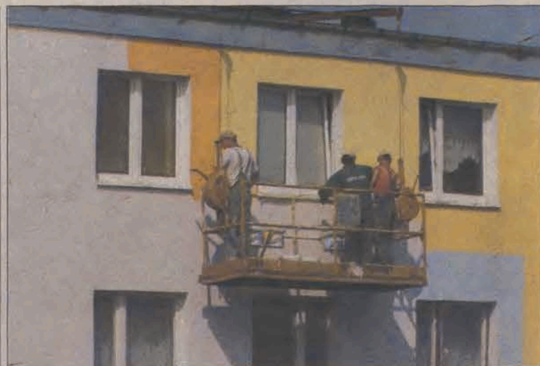
Ósemka z kolorową elewacją. Słoneczna aura sprawiła, że w ubiegłym tygodniu przeprowadzono ostatni etap dociepleniowych bloku nr 8 na osiedlu Kopernika w Głownie - a mianowicie malowanie jego elewacji. Jest ona wyjątkowo kolorowa, bo żółto-niebiesko-zielono-pomarańczowa.
