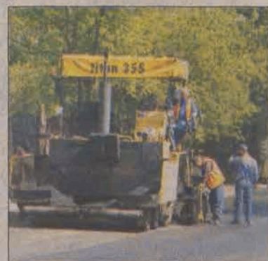
Tak to wyglądało podczas prac.
