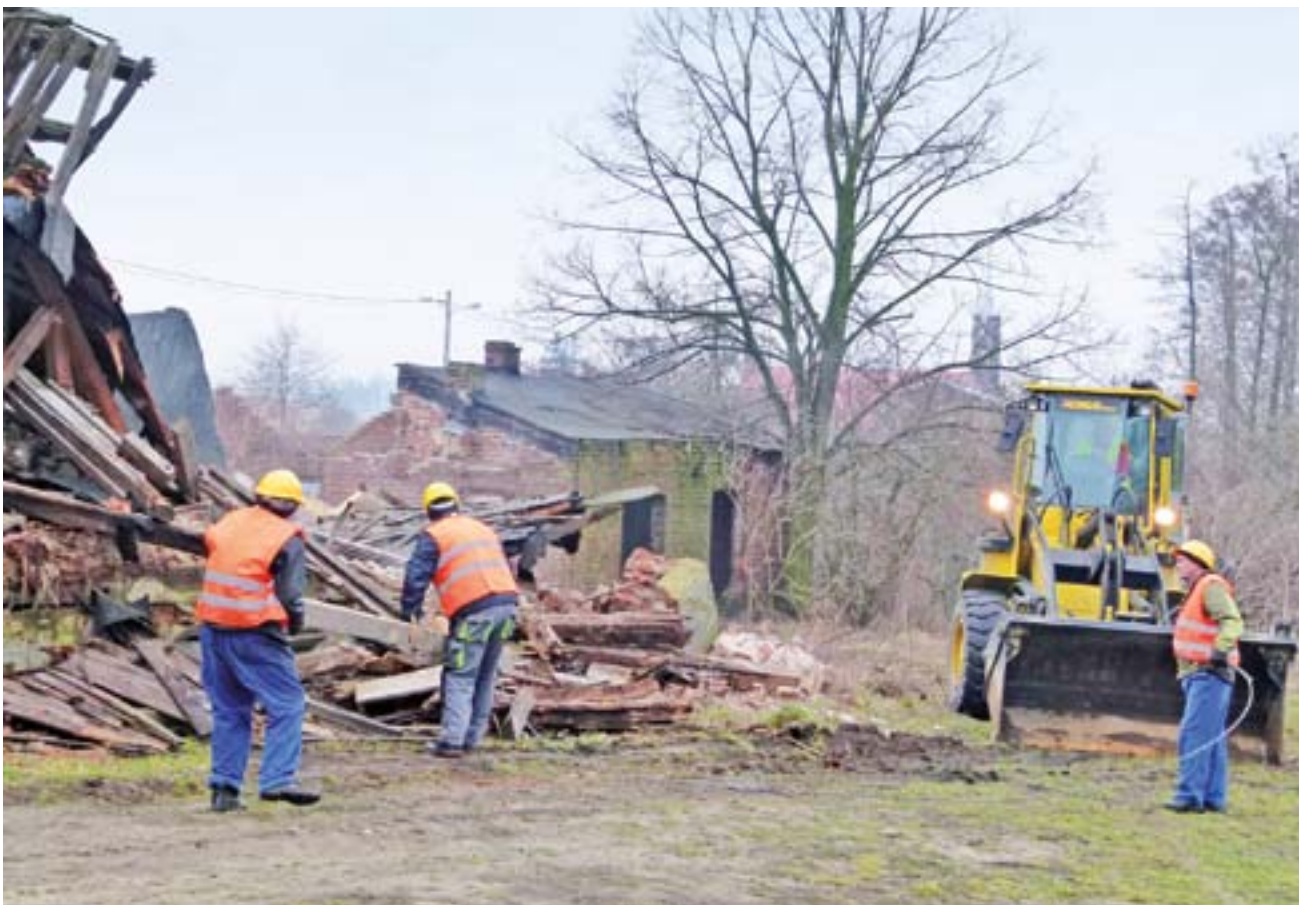
Prace rozbiórkowe prowadzi ekipa Jednostki Robót Publicznych w Strykowie, która przy pomocy ciężkiego sprzętu wyburza dom i na bieżąco uprząta spróchniałe drewno i gruz.
