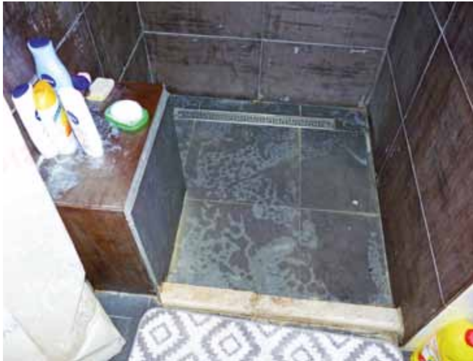
Pod prysznicem nie został odpowiednio ustawiony spadek, dlatego gdy ktoś z niego korzysta, woda zalewa mieszkanie. Rodzina musiała poradzić sobie z tym problemem, montując taki oto, drewniany próg.
