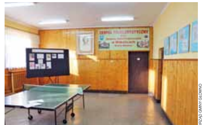
Pożegnanie z boazerią i lastriko. Korytarz ZSP w Mąkolicach w dotychczasowej estetyce. Po remoncie zniknąć ma boazeria, a podłoga ma zostać wyłożona płytkami.
