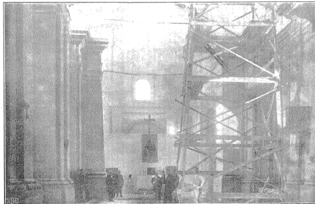
Prace restauracyjne wewnątrz klasztoru.
