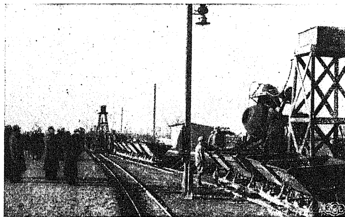
Dowozenie mieszarkami betonu. Mieszarki pracują za pomocą motorów.
