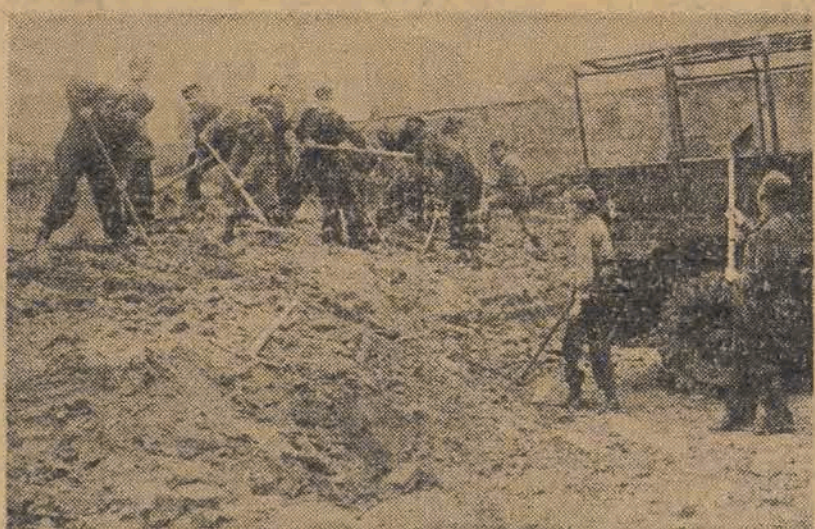
Łódzka młodzież szkolna z zapnem pracuje dla dobra swego miasta. W ramach S. P. grupy uczniów zatrudniane są po 3 dni przez kilka godzin przy uprzątnięciu i porządkowaniu ulic. Oto dzielni chłopcy z Gimnazjum Nr 10 na Widzewie uprzątnają gruz z placu przy ul. Ogrodowej.
