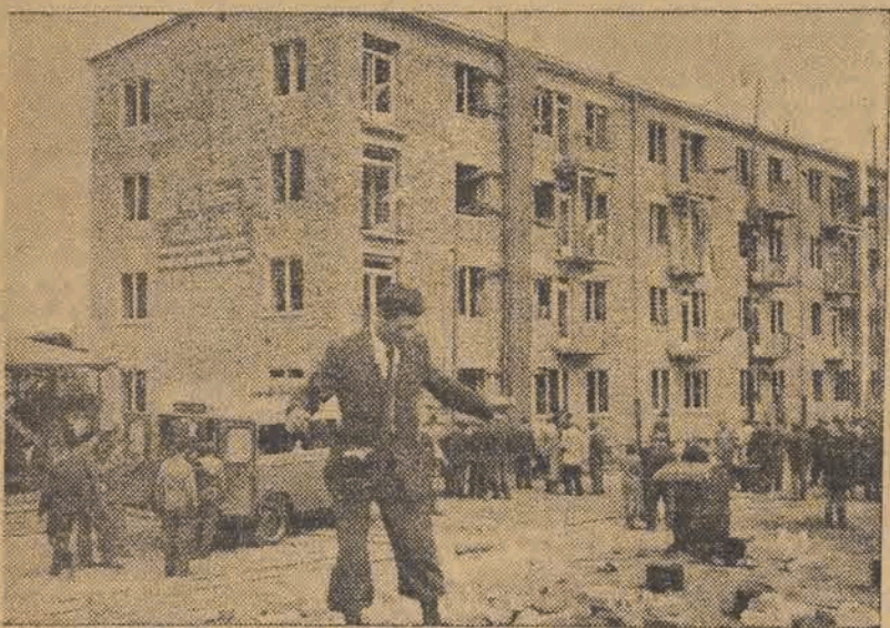
1 września zakończono budowę szybkościowego domu w Warszawie. Budynek wykonano w ciągu... 12 dni.
