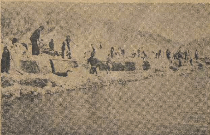
Budowa kanału Maliq w Albanii.
