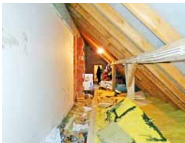
Prace dociepleniowe w pierwszej kolejności rozpoczęły się nad lewą nawą kościoła na Korabce.
