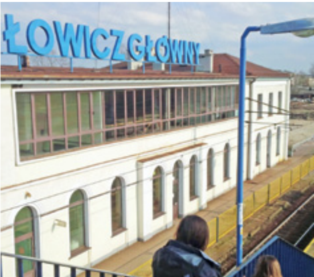
Budynek dworca Łowicz Główny też będzie musiał zostać wyremontowany, ale zakres robót nie został jeszcze ustalony.
