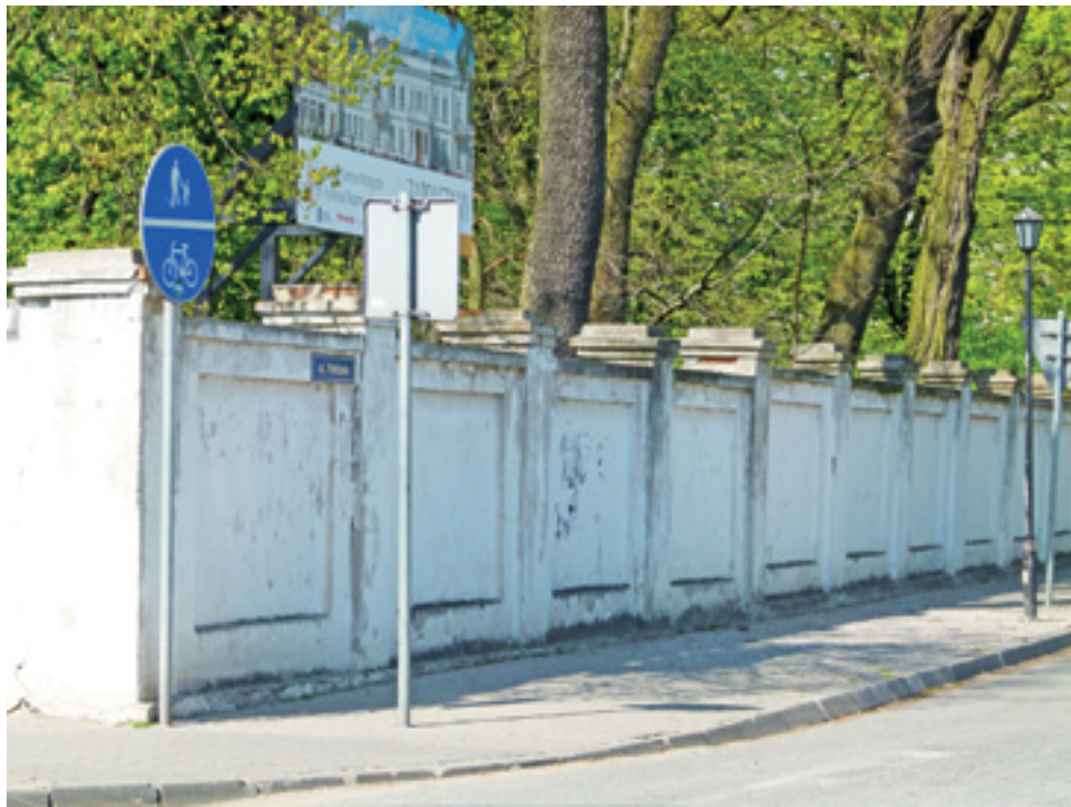
Ogrodzenie ma zabytkowy charakter od strony ul. Warszawskiej, ale od strony ul. Parkowej – widocznej na zdjęciu – będzie zamienione na ażurowe.
