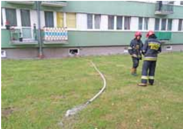
Wypompowywanie wody z piwnic bloku nr 6.
