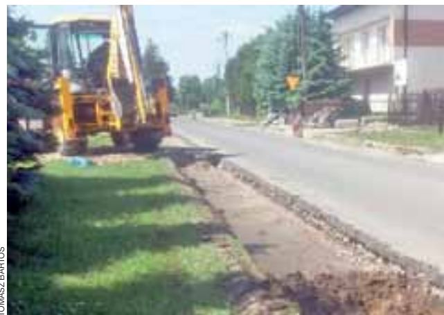
Prace przy poszerzeniu drogi trwają w Kompinie i Patokach w gminie Nieborów.
