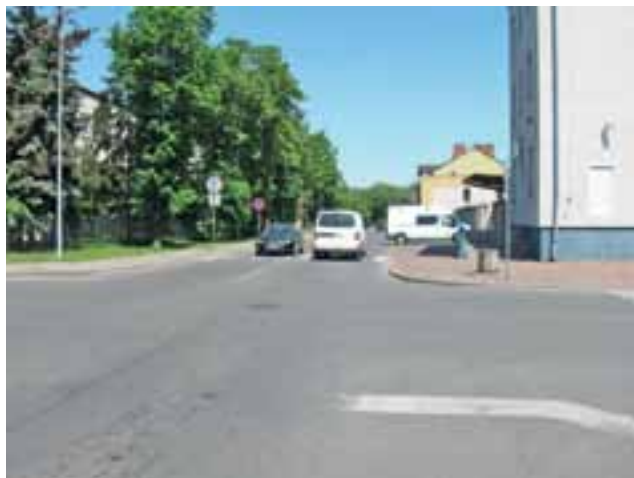
Zdjęcie nr 2. Brak pionowego znaku „przejście dla pieszych” przez jezdnię ul. Bonifraterskiej przed wyznaczonym miejscem przejścia dla pieszych – widok od ul. Długiej w kierunku ul. Podrzecznej w Łowiczu.
