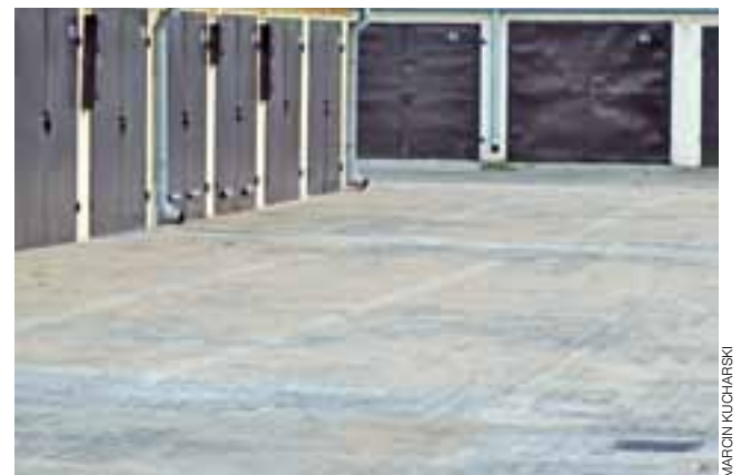
W części kompleksu garaży na Bratkowicach nowa nawierzchnia już została ułożona. Kolejnych robót należy spodziewać się w najbliższych dniach.
