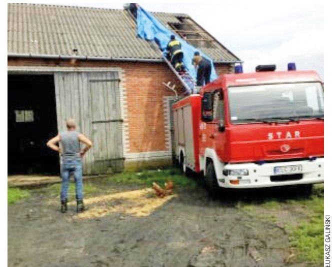
Janinów, 28 czerwca. Zabezpieczanie uszkodzonego dachu na budynku gospodarczym.
