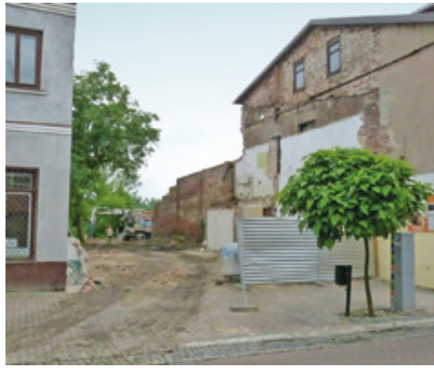
Właściciele chcieliby już rozpocząć budowę nowego obiektu w miejscu wyburzonej kamienicy przy „uskoku” Zduńskiej.
