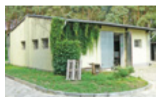
Budynek dawnej tzw. rakarni jest obecnie wykorzystywany jako zaplecze schroniska.
