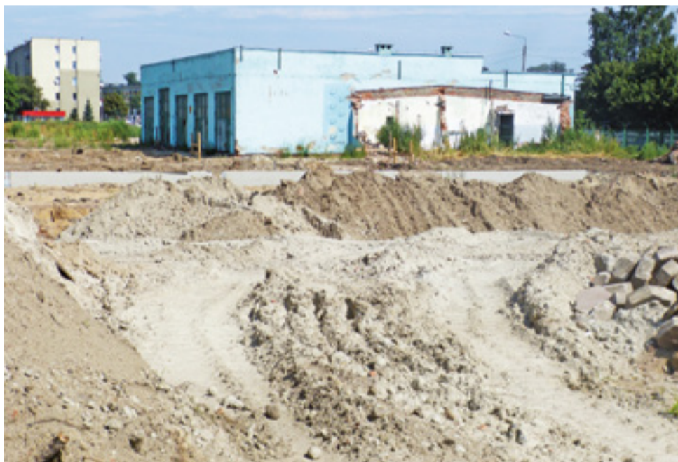
Widać już zarys podstawy powstającego obiektu usługowo-handlowego.
