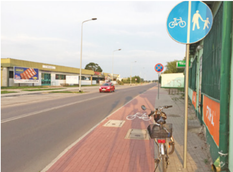
Początek ul. Piłsudskiego: wzdłuż nowej arterii od razu droga rowerowa, z rozdzieleniem ruchu rowerowego od pieszego. Z kostki betonowej, na szczęście nie fazonowej.
