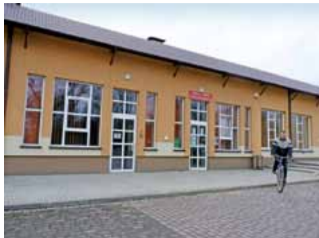
Po rozpoczęciu remontu budynku urzędu większość ważnych dla petentów wydziałów zostanie przeniesiona do pomieszczenia Gminnego Centrum Promocji i Informacji.
