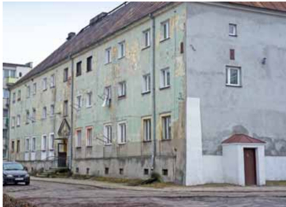
W tym roku będzie zrobiona druga połowa elewacji na budynku bloku Narutowicza 75. Rok temu zrobiono jedną ścianę wschodnio-południową oraz szczyt bloku od strony Narutowicza. Elewacja na tym bloku była najgorsza na całym osiedlu Wyzwolenia.
