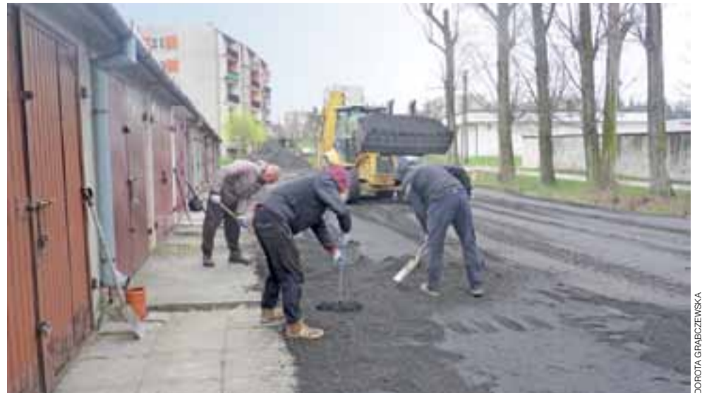
Prace związane z nowym utwardzeniem terenu przed garażami Spółdzielni Mieszkaniowej Emit przy ulicy Żeromskiego wykonują pracownicy Mig-My.
