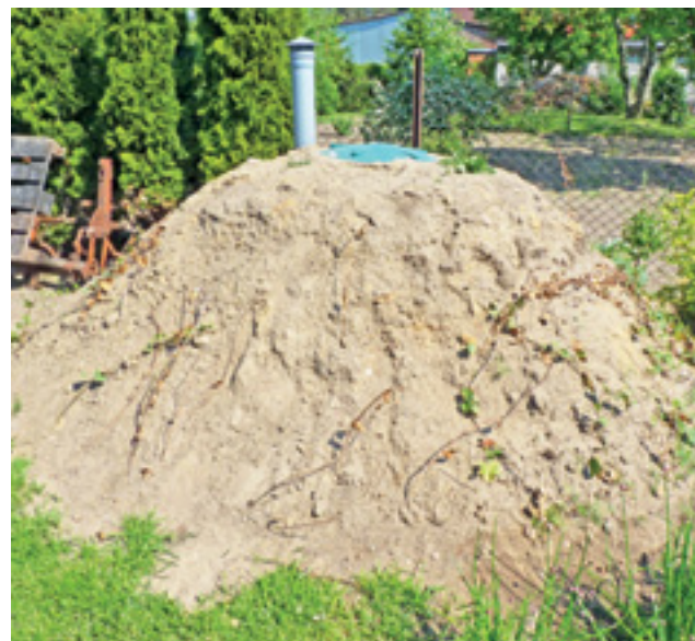
Tak wygląda kopiec przydomowej oczyszczalni ścieków.
