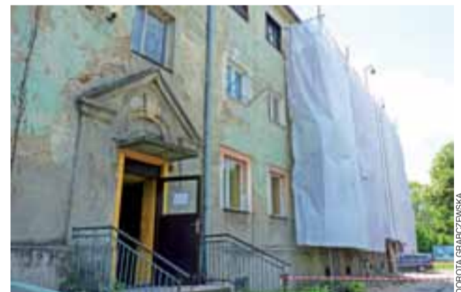
Prace przy elewacji drugiej połowy bloku przy Narutowicza 75 rozpoczęły się 18 maja. Najpierw został całkowicie skuty stary tynk.
