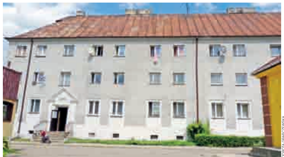
Blok Narutowicza 75 jest najbardziej zadłużony. Lokatorzy zalegają z zapłatą ponad 58 tys. zł. Mimo tego spółdzielnia zakończyła remont elewacji zewnętrznej, który trwał 2 lata.
