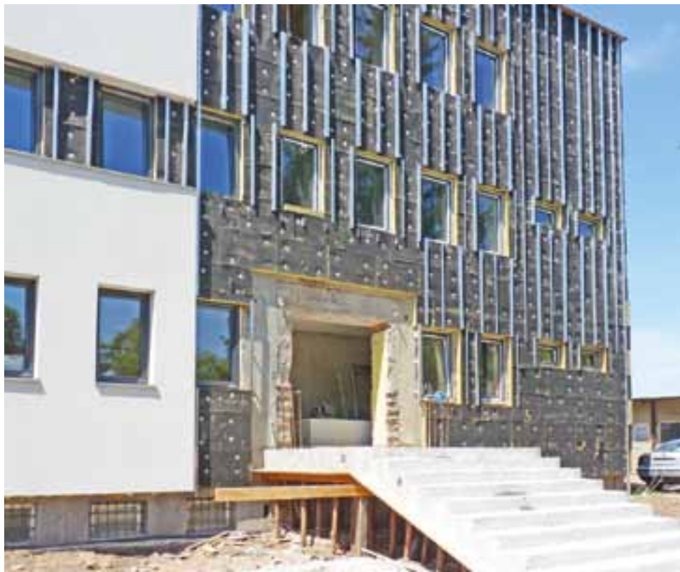
Tak wygląda frontowa część budynku UG. Wylano nowe schody wejściowe, zaś wkrótce ta część elewacji zostanie wyłożona grafitowymi płytami equiton.
