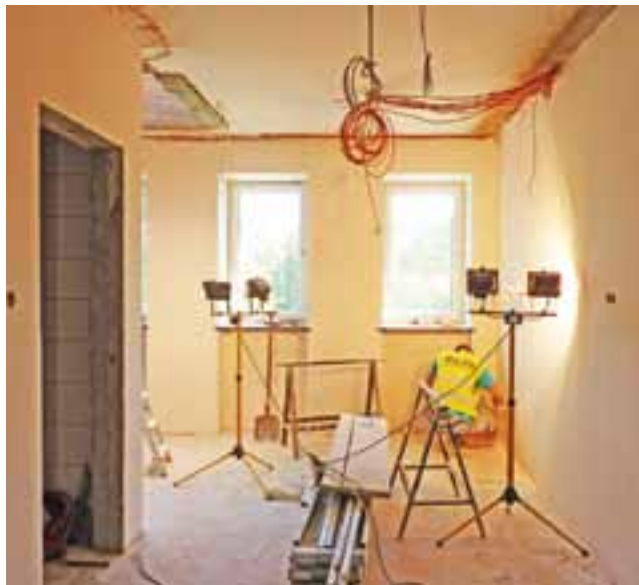
Trwają ostatnie prace na II piętrze. Po niedzieli będzie układana podłoga tarkettowa.
