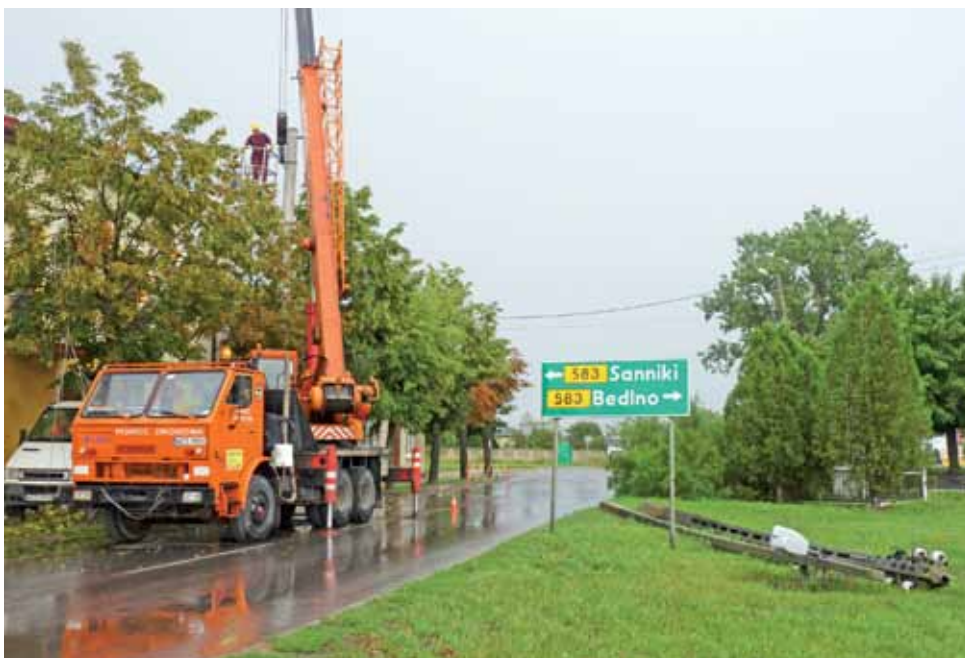
Przez kilka dni trwały inwestycje w ulicy Plac Wolności w Żychlinie. Wymieniono 5 słupów wraz z linią napowietrzną oraz zmodernizowano oświetlenie uliczne.
