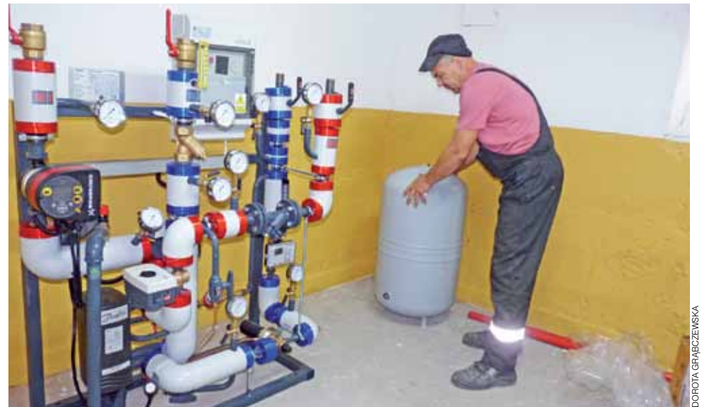
Jan Włodarczyk, pracownik firmy Hydro-Tech, podczas podłączania węzła cieplnego w bl. Narutowicza 79/II.
