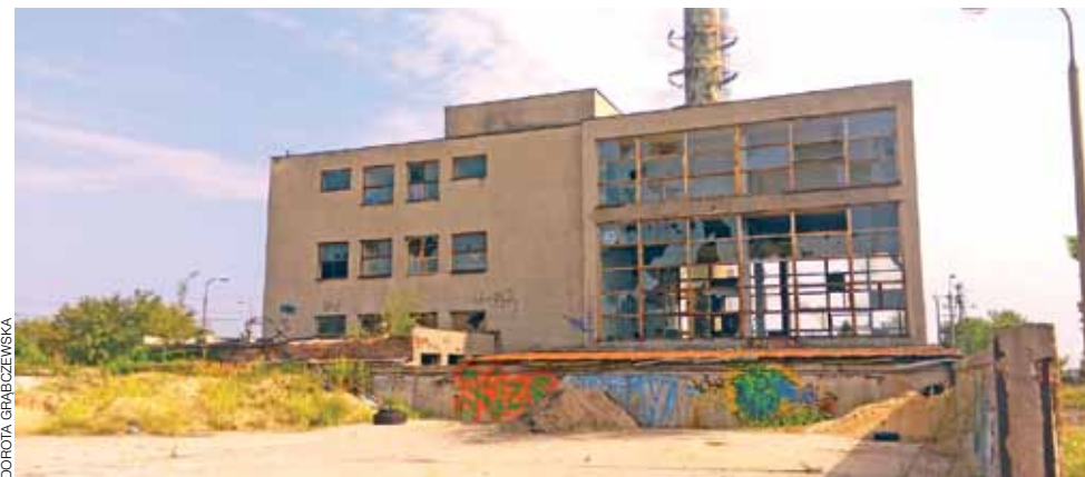
Budynek po starej kotłowni szpitalnej wkrótce zniknie z horyzontu. Wyburzenie będzie dokonywane z użyciem materiałów wybuchowych.
