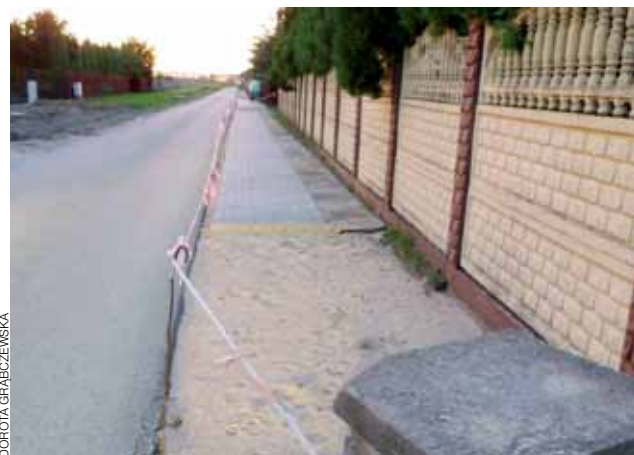
W sobotę 16 lipca do ułożenia pozostawało jeszcze ok. 2 metrów chodnika.
