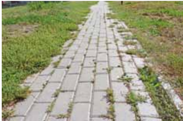
Chodniczek, będący przejściem od Hanki Sawickiej do punktowca Hanki Sawickiej 7, obok miejskiej hydroforni, po 2 latach od ułożenia kostki polbrukowej w wielu miejscach mocno już zarósł trawą, w niektórych miejscach brakuje płytek. Czekają na oczyszczenie.
