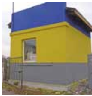
Tak wygląda wyremontowany budynek socjalny przy targowisku.
