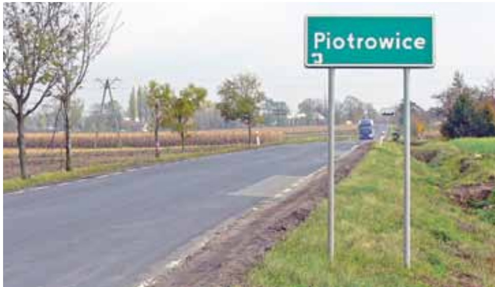
W oczekiwaniu na przyszłoroczny remont. Droga wojewódzka nr 703 na wysokości Piotrowic w gm. Bielawy.
