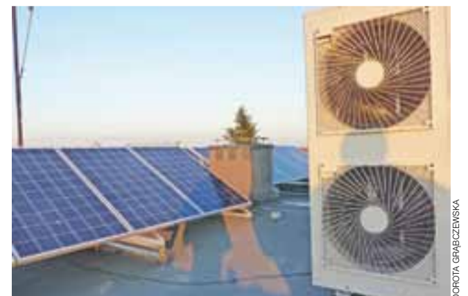
Na dachu urzędu zamontowano panele fotowoltaiczne o mocy 10 kW oraz agregaty klimatyzacji chłodząco-nagrzewającej dla 24 pomieszczeń.
