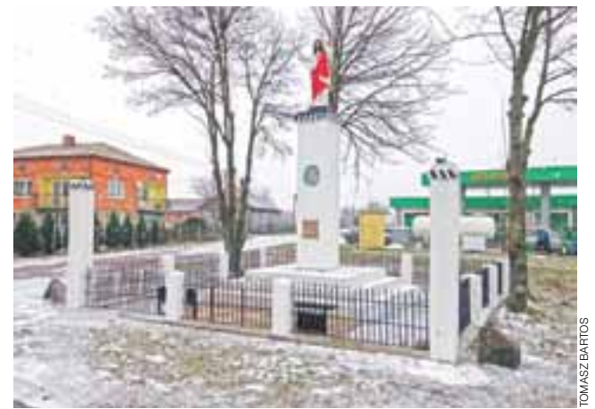
Po renowacji kapliczka w Bednarach wygląda jak nowa, tymczasem liczy sobie już prawie 100 lat.
