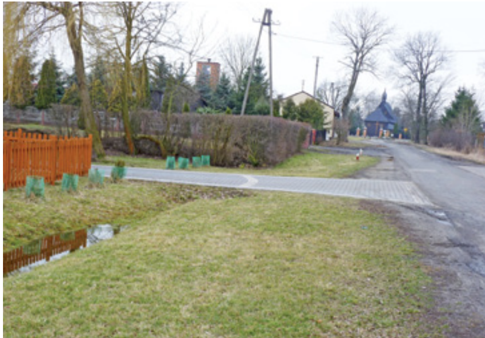
50 m za strażnicą (żółty budynek po lewej stronie) znajduje się rów gminny. Czy rowu tego nie można przedłużyć o kolejnych 100 metrów?
