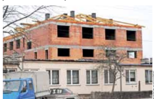
Widac już konstrukcję dachu na nowym budynku MOS w Kiernozi.
