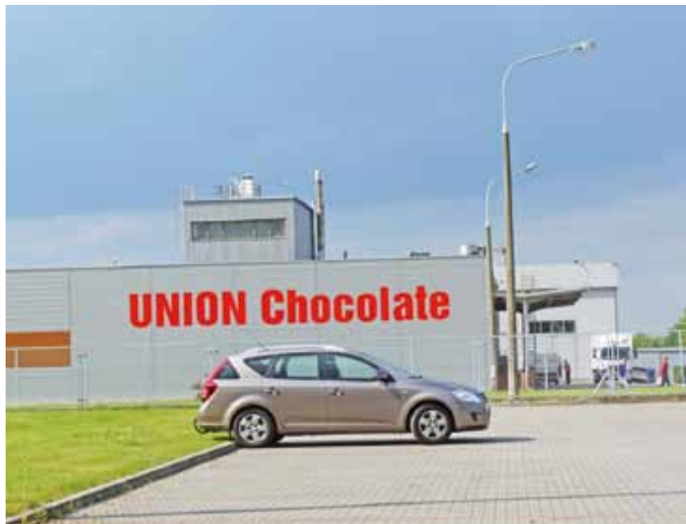
W ramach nowej inwestycji robiona jest termomodernizacja obiektu. Nazwa firmy widoczna jest teraz z daleka.
