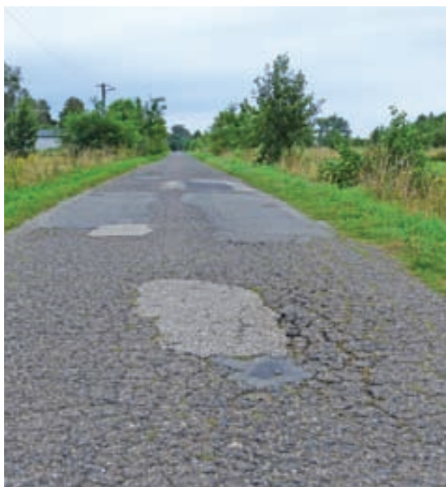
Asfalt na ul. Wschodniej w Nieborowie najlepsze lata ma dawno za sobą. Widać na nim liczne zadolenia, spękania i łaty.
