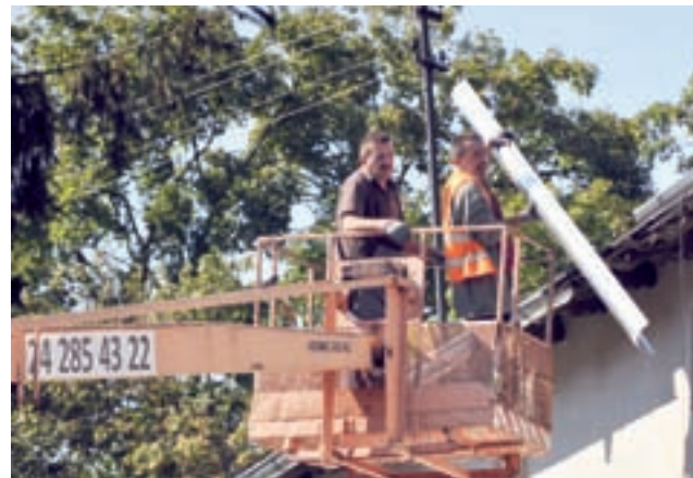
Ekipa remontowa spółdzielni mieszkaniowej Wspólny Dom wymienia rynny na budynku przy ul. Narutowicza 71.
