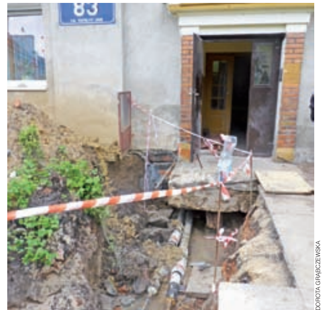
Energa Kogeneracja w piątek podłączyła sieć ciepłowniczą do bloku Narutowicza 83.
