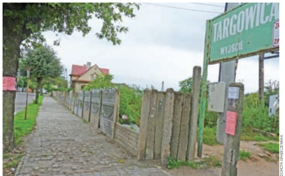
Chodnikowy bruk na dojeździe do targowiska jest w wielu miejscach bardzo zniszczony.
