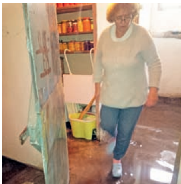
Genowefa Rojewska z budynku przy ulicy Łąkowej 3 w Żychlinie sprząta piwnicę po wypompowaniu wody.
