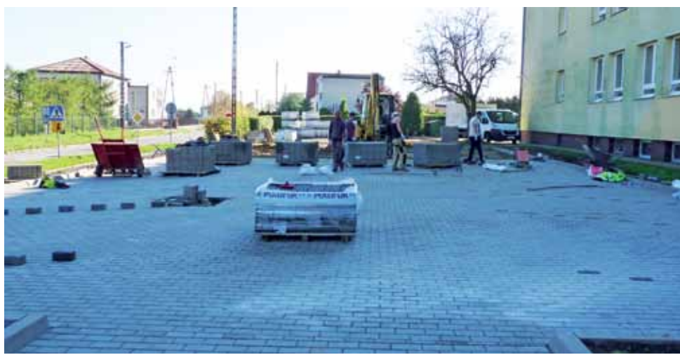
Przy ZSP nr 2 budowany jest parking na 20 samochodów.
