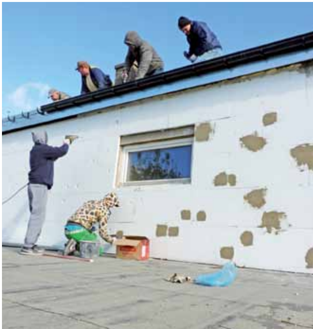
Pracownicy Mig-Ma kończą obróbkę blacharską i zakładanie rynien. Docieplili też część muru świetlicy. Po zakończeniu tych prac ułożą jeszcze papę termozgrzewalną.
