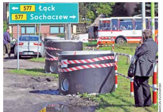
Gmina będzie mogła „podpiąć się” z kolektorem, którym będą odprowadzane wody deszczowe z terenu się w sąsiedztwie szkoły.
