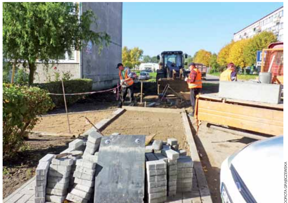
Pracownicy żychlińskiego Budomatu pracują przy wymianie kilkudziesięciu metrów starego chodnika na nowy i równy przy bloku Łąkowa 9. Przy okazji tych prac zostanie zrobiony niewielki parking dla kilku samochodów. Teraz miejsc parkingowych brakuje, a kierowcy parkują auta wzdłuż ulicy. dag
