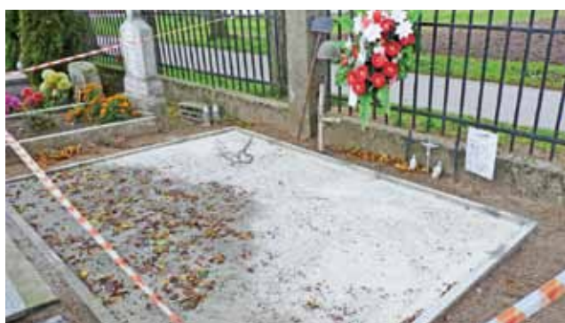
Teren budowy nowego pomnika bohaterom września 1939 r. zrobiono betonową wylewkę. Są też stare tablice z nazwiskami poległych 6 żołnierzy oraz żołnierski hełm zatknięty na kiju. Na nowej tablicy zostaną dopisane dwa nazwiska: szer. Zygmunta Skroma i szer. Michała Szeluto.
