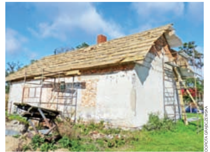
Trwa remont dachu i elewacji świetlicy wiejskiej w Kaczkowiznie.
