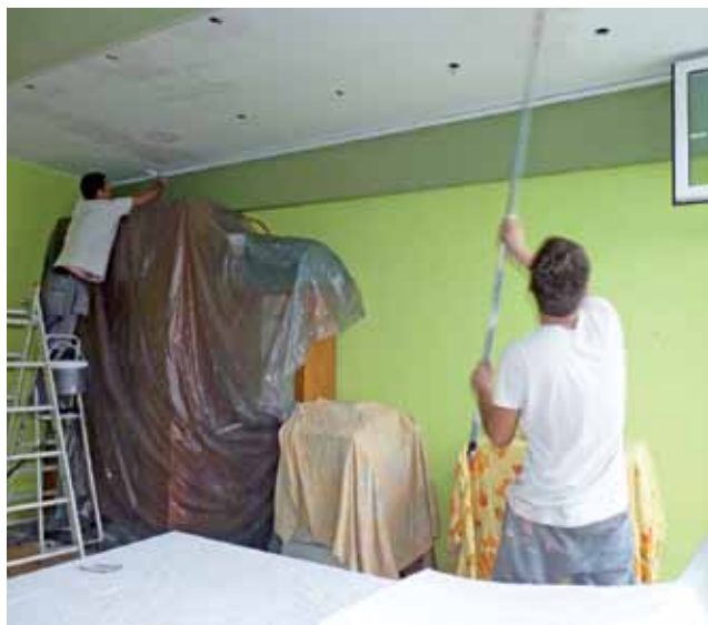
Pracownicy firmy Elvis malują pomieszczenia domu kultury, które w trakcie prac modernizacyjnych zostały zalane.
