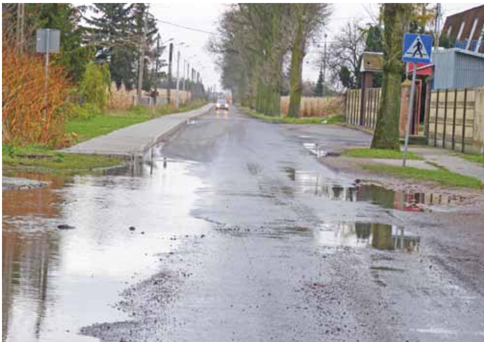
Starostwo w listopadzie ma rozpiścić drugi przetarg na modernizację stu metrów ulicy Jabłonkowej wraz z budową kanalizacji deszczowej, by woda nie stała na drodze.
