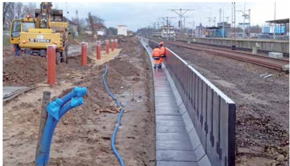
W tym miejscu powstanie peron 1.
