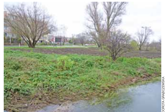
Na terenie nad Studnią rozpoczęto prace przy zakładaniu skweru. Na razie wyrównano teren i zlikwidowano dziką łąkę.
