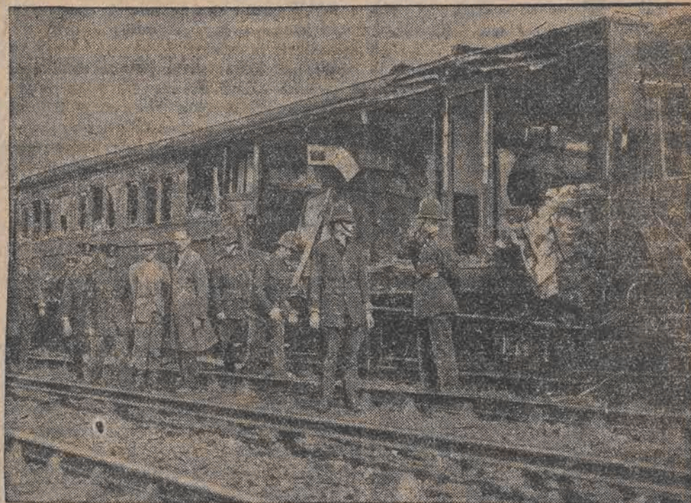
W czasie zderzenia pociągów pod Londynem sześć osób zostało zabitych, 40 rannych. — Na ilustracji wydobywanie ofiar z gruzów rozbitych wagonów.
