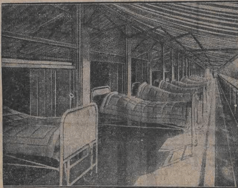
Das neueste Sanatorium für Tuberkulose, das in Marburg (Deutschland) dem öffentlichen Gebrauch übergeben wurde, stellt ein zweistöckiges Gebäude von 160 Meter Länge dar mit reizender Aussicht auf bewaldete Gebirgshöhen und ist mit den neuesten medizinischen Appara-
