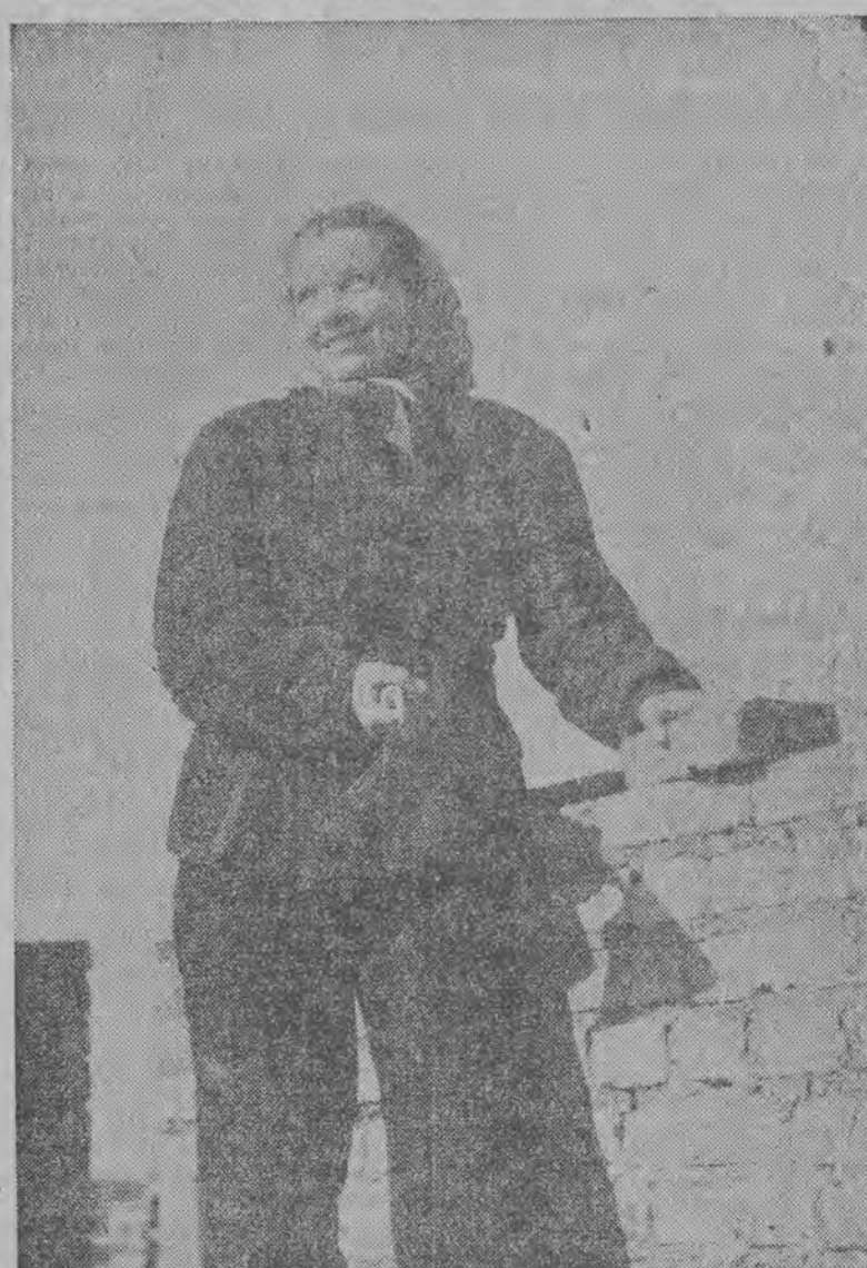
Jadwiga Leśkiewicz ze Zgierza — brygadystka Państw. Przeds. Budowlanego — zobowiązała się wraz ze swoją brygadą wykonywać w czasie od 1 kwietnia do 1 października rb. —130 procent normy. Ob. Leśkiewicz wzywa wszystkich pracowników budowlanych do pójścia w jej ślady.
